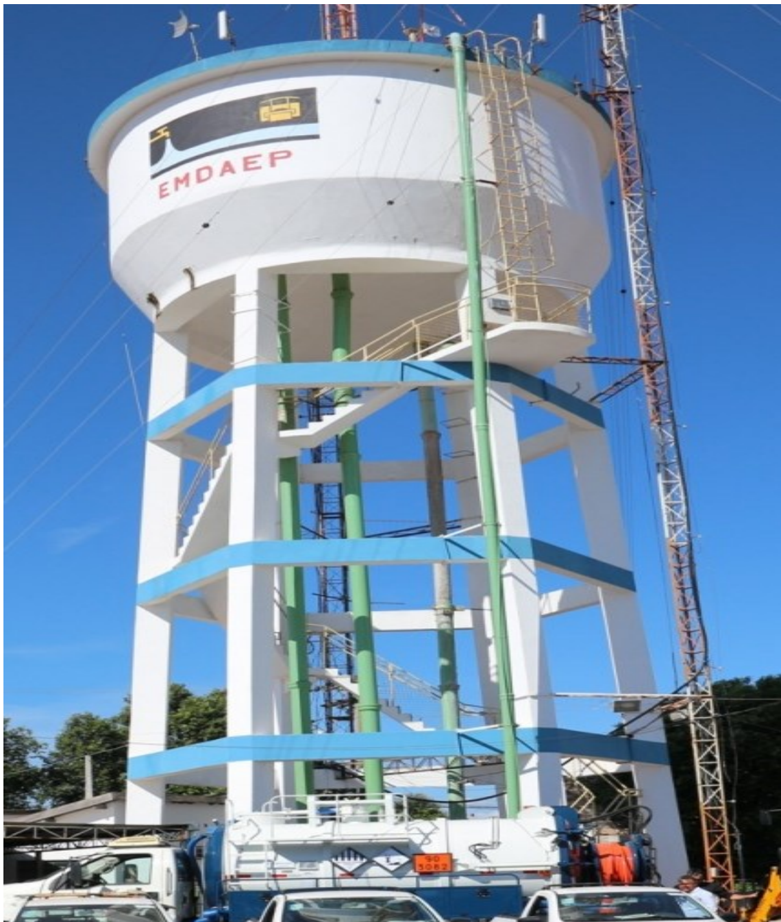
Caixa d'água elevada com capacidade de 460 m 3 .
