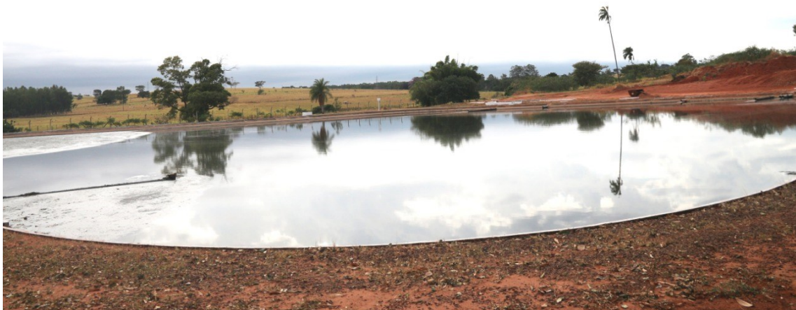
Lagoa de Tratamento do Bairro das Antas
