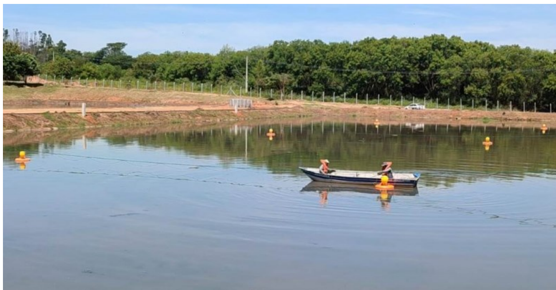
Instalação de aeradores Na ETE Bairro Mirassol
