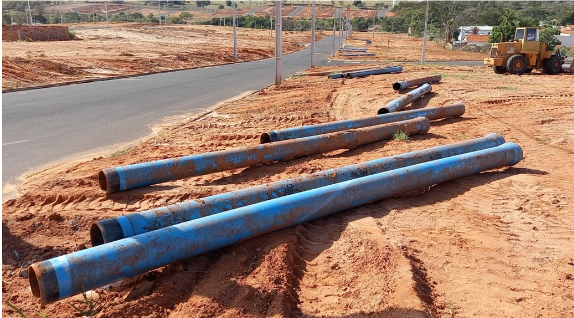
Reaproveitamento de tubos para futura construção de emissário de esgoto
