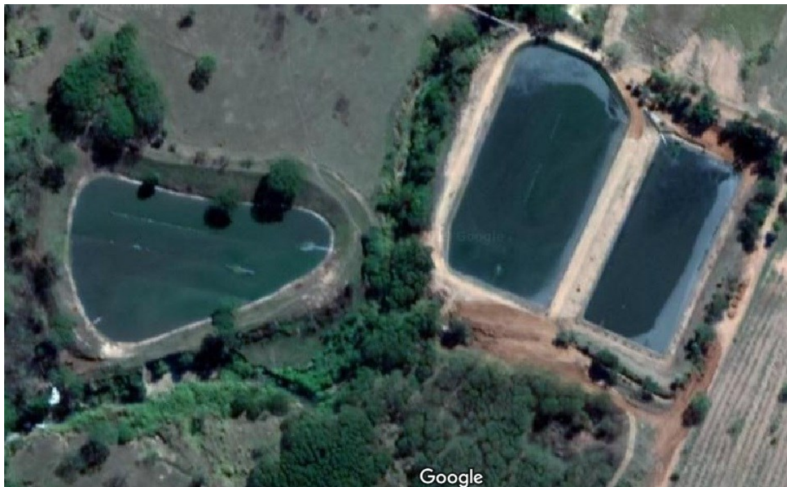
ETE Bairro Mirassol (vista aérea)
